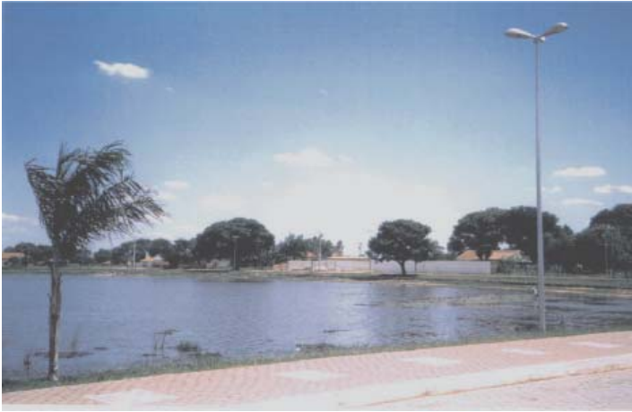
Figura 12: Vista panorâmica da região sudoeste da lagoa em 2005. Nesta foto é possível visualizar várias implementações como: em primeiro plano, pavimentação primária, iluminação, calçamento, arborização. E em segundo plano, o alteamento do entorno e a barreira de conformação.
