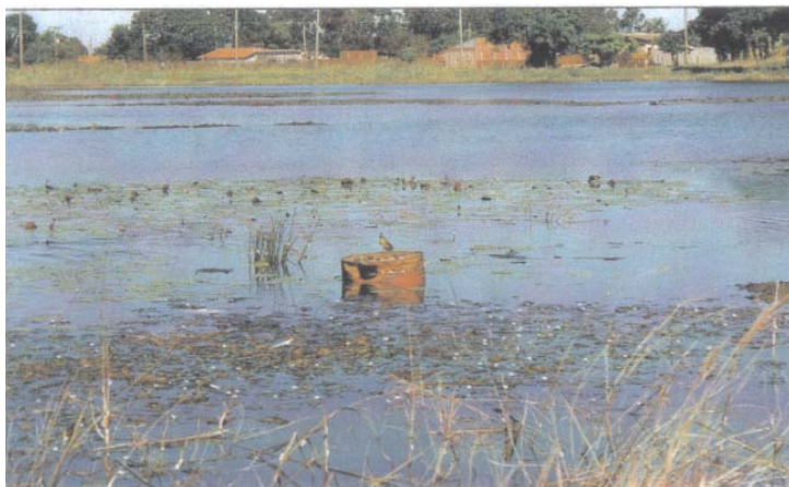
Figura 2: Vista panorâmica da região sudeste da lagoa em 2002, antes do início da obra. No meio da lagoa observa-se a presença de lixo e grande quantidade de plantas aquáticas flutuantes fixas. E ao fundo, na margem sudeste, plantas terrestres.
