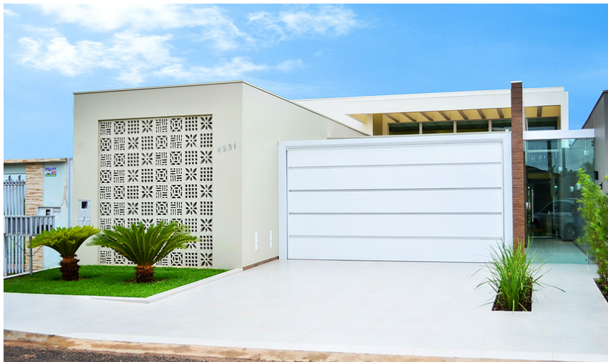
Figura 11 – Fachada de casa com cobogós estilo retrô e arquitetura contemporânea. Projetado por Giordano Rogoski
