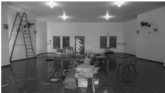
Figura 5: Capela em reforma.
